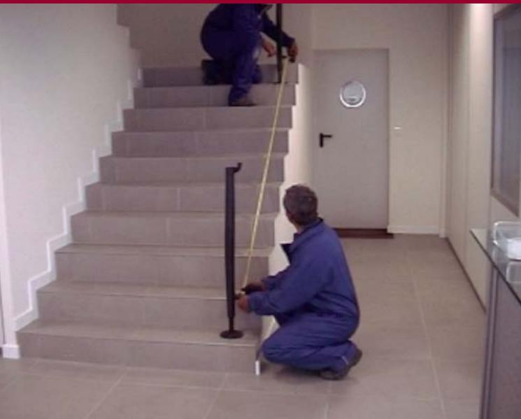
Realizar una medición exacta del espacio donde se va a efectuar el montaje. Hacemos un premontaje de las bases a las columnas, atornillando hasta la altura necesaria (desde la línea de inclinación definida por los vértices de los peldaños, hasta el límite superior de la barrera que debe ser de 900mm. medidos verticalmente, CTE).
