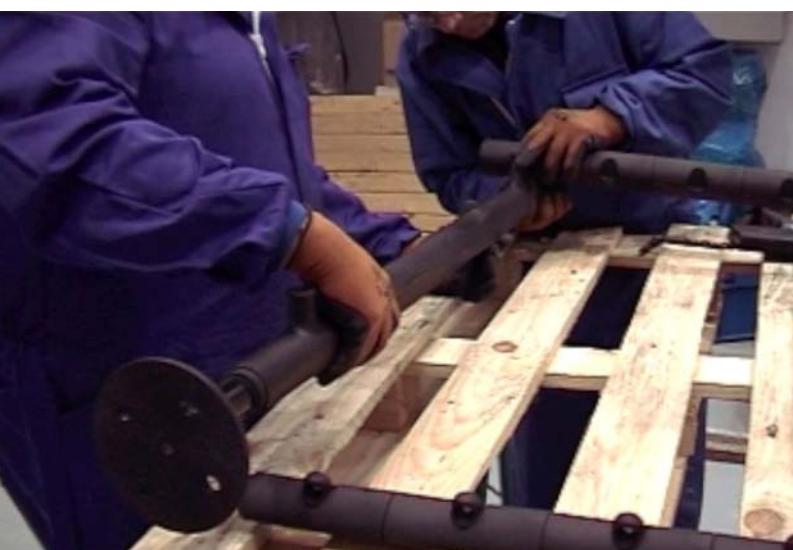
Una vez formados estos los atornillaremos a las columnas de los extremos. Es recomendable afinar el ajuste de la altura de las columnas mediante la regulación de la base. Añadiremos columnas si fuera necesario, cada 1 - 1,5m, adaptándonos a cualquier tipo de huella o inclinación de la escalera.
